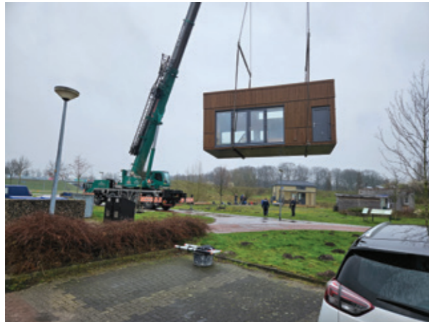
Nieuwe huisje Rappad 1 wordt geplaatst
